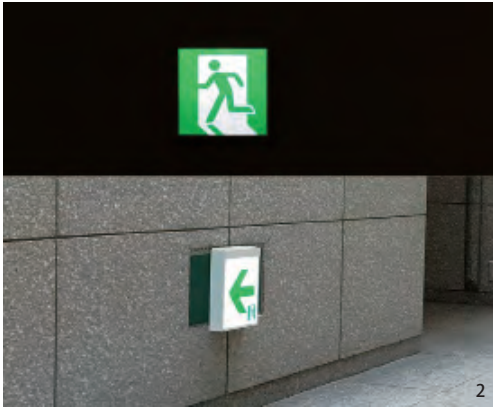
1. 日本现行标准方案（左）与小谷松方案（右）对比 2. 现行日本 JIS 标准“紧急出口”的两种方式：终点（上）与路径方向（下）
